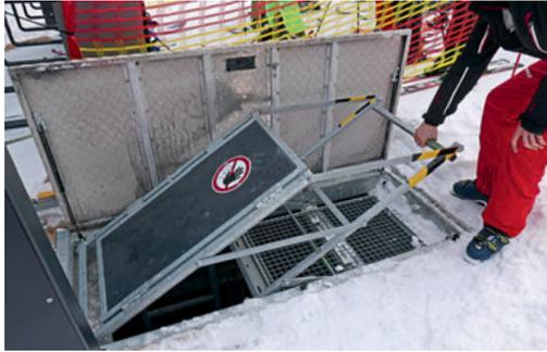
**Chairkit** brachte als Neuheit zur Messe einen klappbaren Abstieg in die Fördergrube des Sesselliftes mit. Der Vorteil ist – neben einer besseren Optik – dass der Seilbahn-Mitarbeiter nicht von dem Gelände in seiner Wartungsarbeit gestört wird. Im geschlossenen Zustand ist die Vorrichtung nicht mehr zu sehen, weil sie ebenerdig abschließt.
