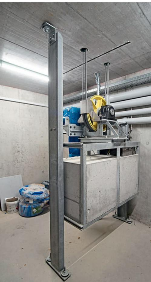
Oben: Auf der teil-offenen, zentral im Gebäude gelegenen Trasse überwindet der Aufzug 20 Höhenmeter mit komfortablen 1,2 m/s.
