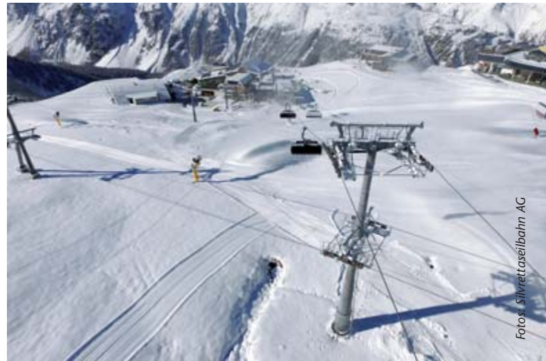
Blick auf die Kreuzungsstütze Höllbodenbahn/Flimjochbahn.
