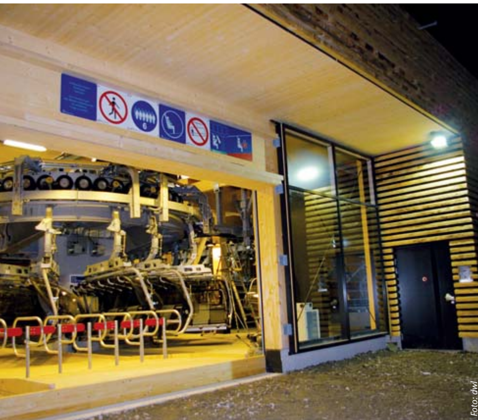
Der Zutrittsbereich der Talstation.
