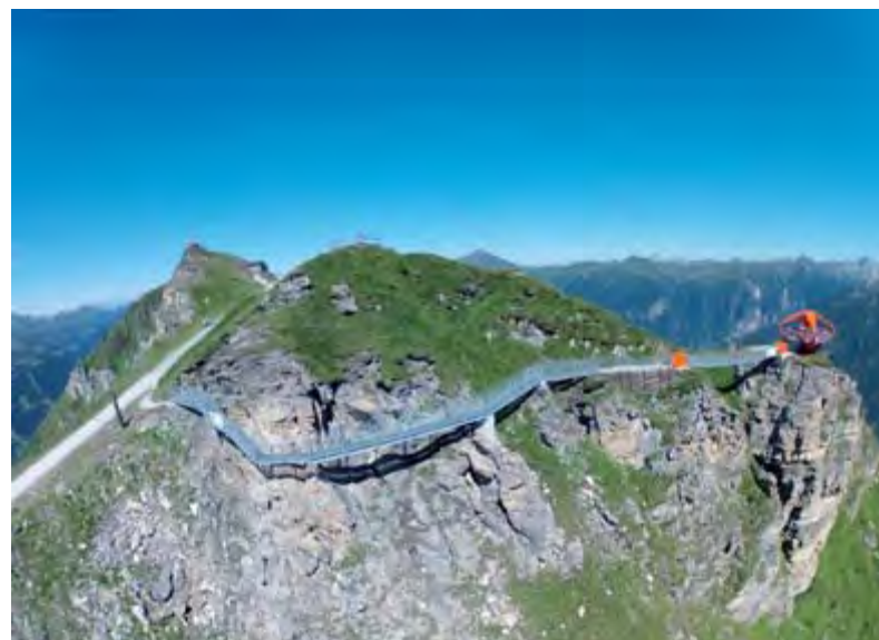
Felsensteig und Aussichtsplattform auf dem Stubnerkogel made by HTB.
