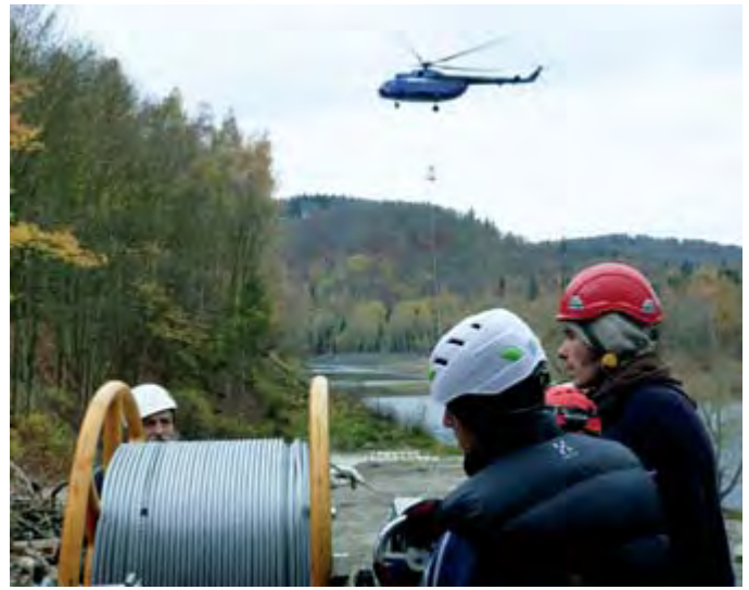
Der Seilzug war eine technische Herausforderung, die mithilfe eines Helikopters bewältigt wurde.
