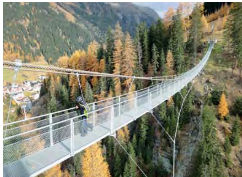
Das Know-how von HTB wird auch immer öfter bezüglich Hängebrücken nachgefragt. Im Bild die „Bärenfalle-Brücke“ in Ischgl.
