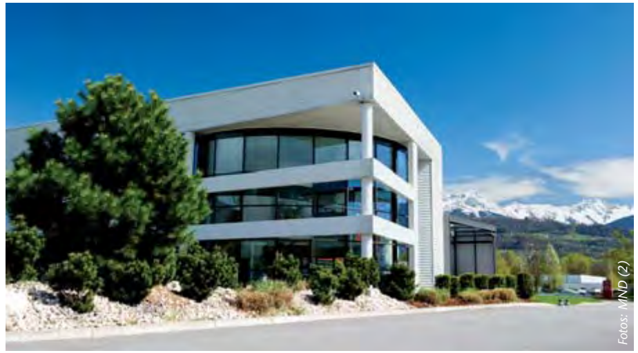
Betriebsgebäude der MND-Gruppe in Saint Helene du Lac, Frankreich.
