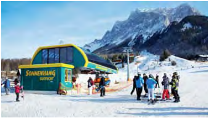
Die Talstation wurde auf 1.040 m Seehöhe gebaut.
