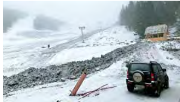
Notwendige Arbeiten werden bei jedem Wetter durchgeführt.
