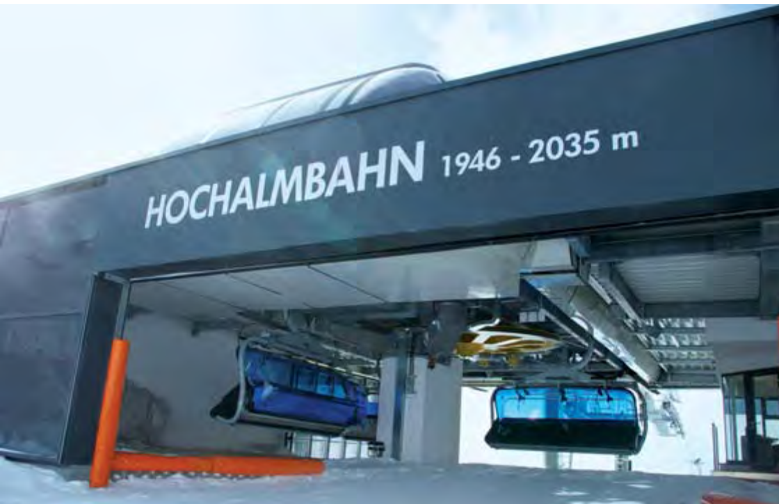
Die Bergstation auf 2035 m Seehöhe.
