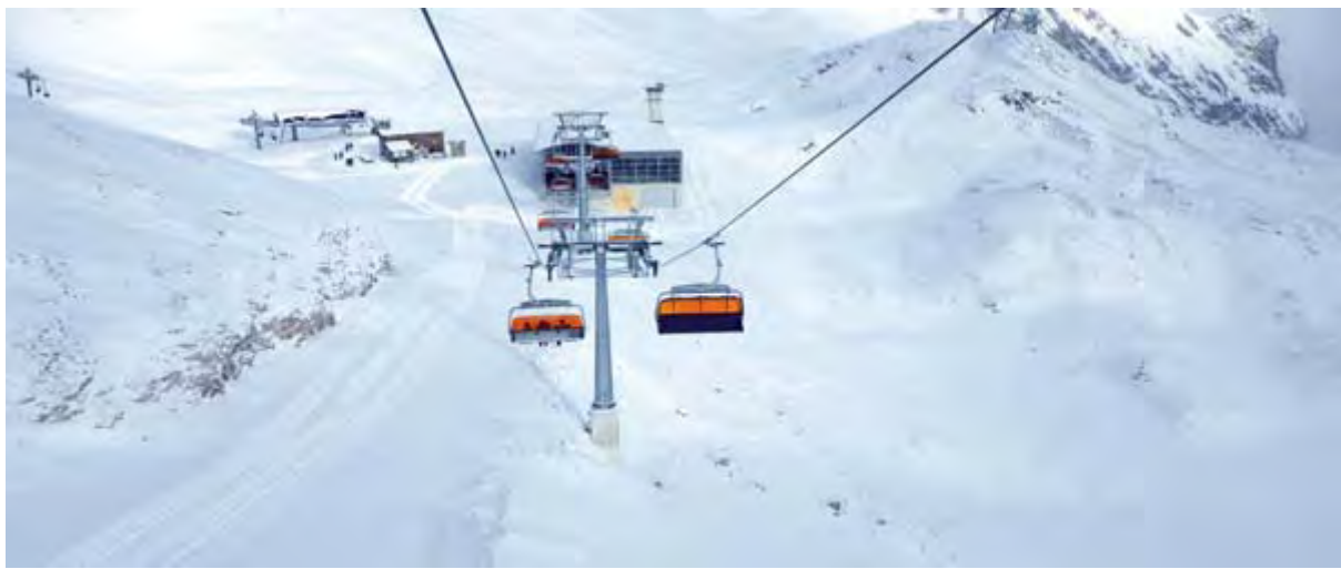
Am Zugspitzblatt in Bayern wurde die Wetterwanddeckbahn fertig gestellt und Anfang Dezember feierlich eröffnet.
