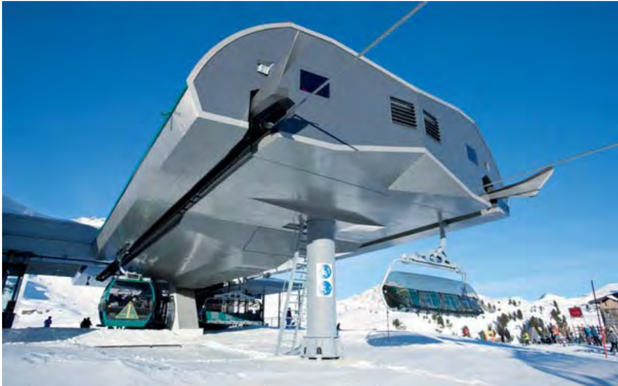
Die Bergstation bietet Antrieb und Abspannung Platz.
