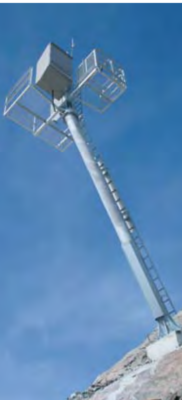
Der Lawinmast von Inauen-Schätti wirft ferngesteuert Sprengladungen an einer Leine ab und bringt sie 2 bis 3 Meter über der Schneedecke zur Detonation.
