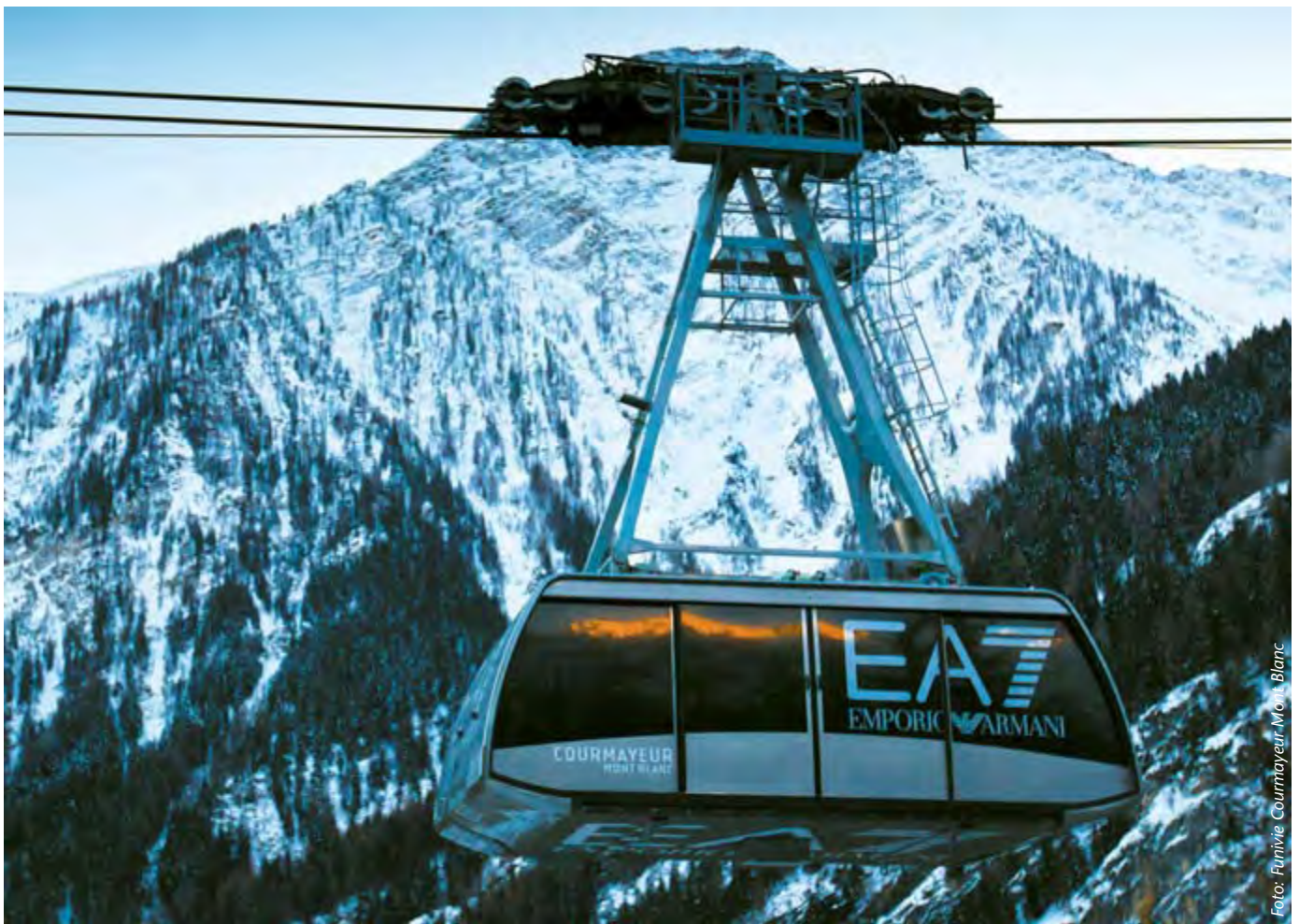
Nur gut knapp acht Monate benötigte Gangloff für Planung, Bau und Inbetriebnahme der neuen 120er-Kabine für die Zubringerbahn Courmayeur – Mont Blanc im italienischen Aosta-Tal.
